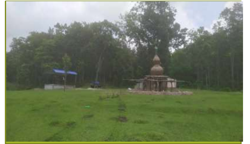
किरात साकेला यलम्बर पार्क वडा नं. १ मा चिण्डो निर्माण
