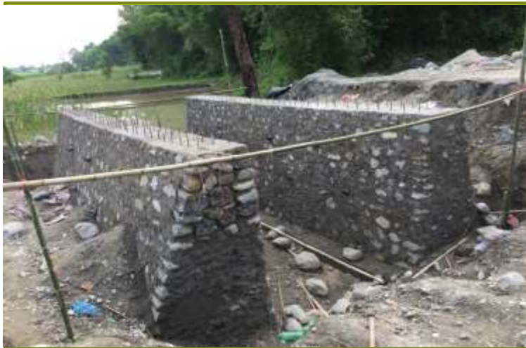
त्रिवेणी चौकबाट धौरी जाने सडकमा स्लाब कल्भर्ट निर्माण
